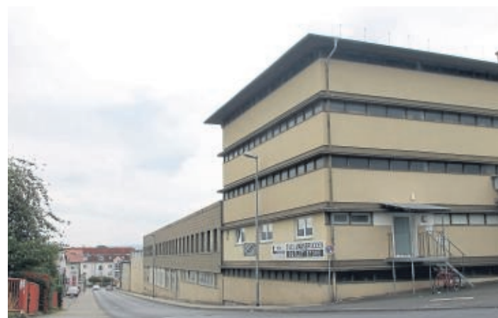
Hier ist das Archiv untergebracht: Im ehemaligen Tuchlager an der Wilhelm-Wever-Straße in Bad Hersfeld.
