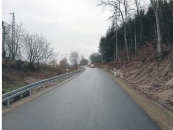
Saniert: Die Kreisstraße zwischen Altenbrunslar und Ellenberg im Bild noch ohne Fahrbahnmarkierung.
